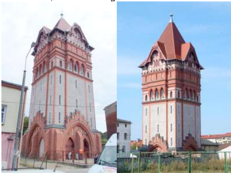
Zdjęcia nr 16, 17. Wieża ciśnień, ul. Paderewskiego
